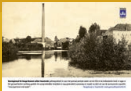
Stoomgemaal De Hooge Boezem achter Haastrecht (1917). De Historische Vereniging Haastrecht gebruikt fotoborden om wandelaars over belangrijke historische plekken te vertellen.
