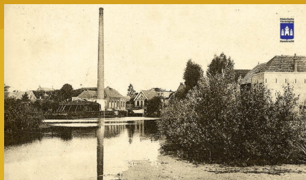
Stoomgemaal De Hooge Boezem achter Haastrecht, gefotografeerd in 1915. Het gemaal pompte water uit de Vlist in de Hollandse IJssel. In 1990 is het gemaal buiten werking gesteld. De oorspronkelijke installatie is nog grotendeels aanwezig en maakt nu deel uit van de permanente expositie "Hoop aan leem met water". Hoogezwaaije | Haastrecht | www.gemaalhaastrecht.nl
